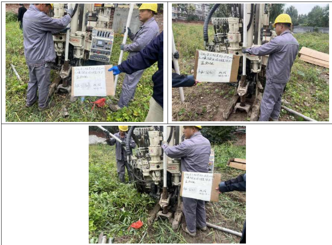
图 6-7 地下水点位下管施工图
