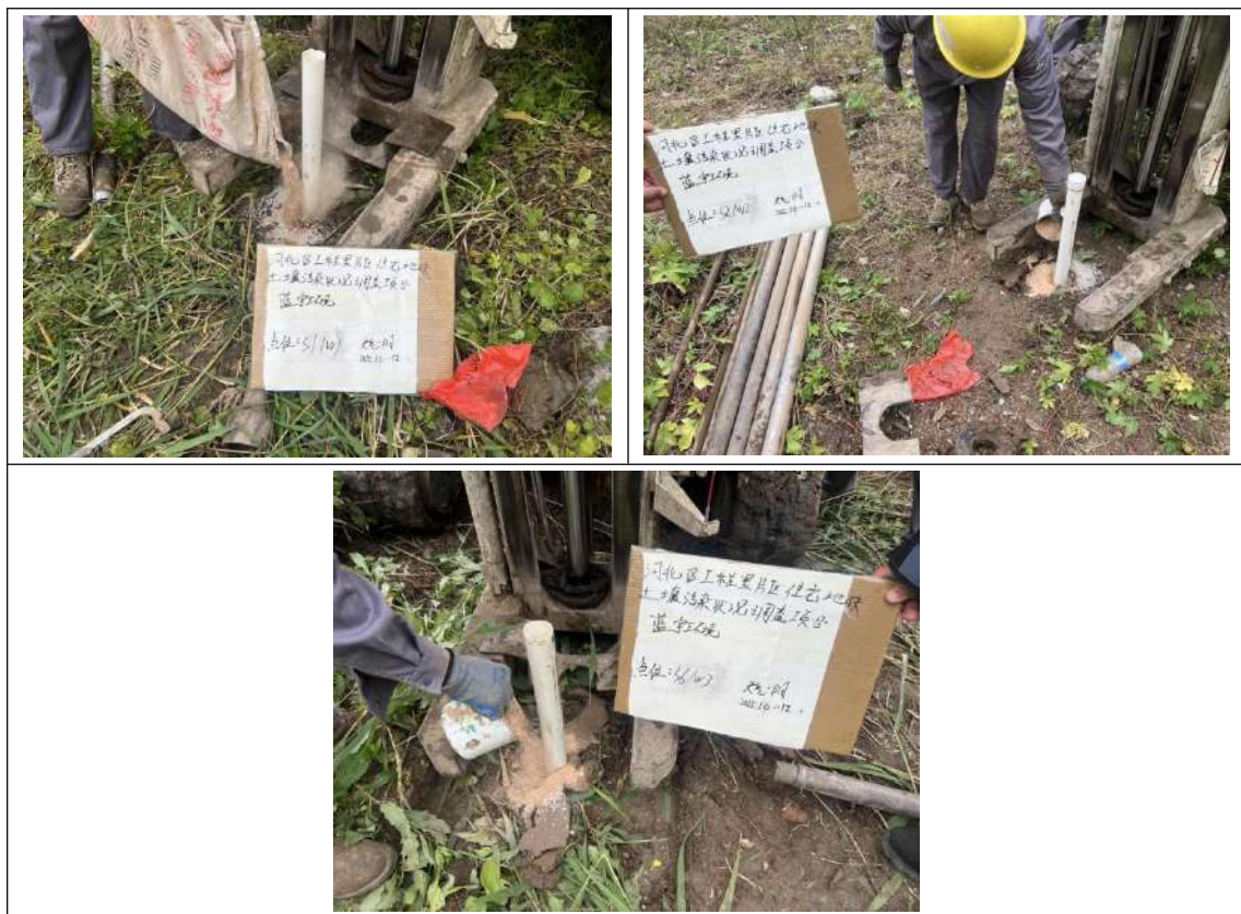
图 6-9 地下水点位密封止水施工图
