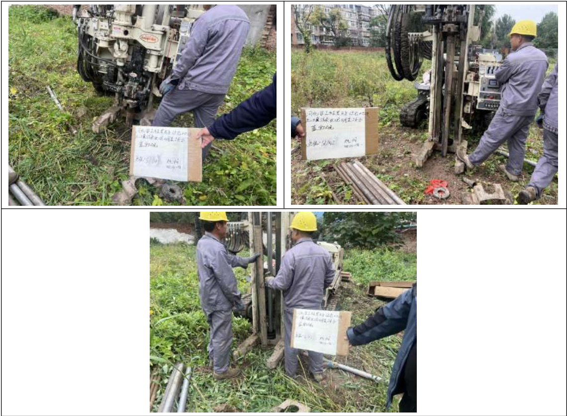
图 6-6 地下水点位钻孔施工图
