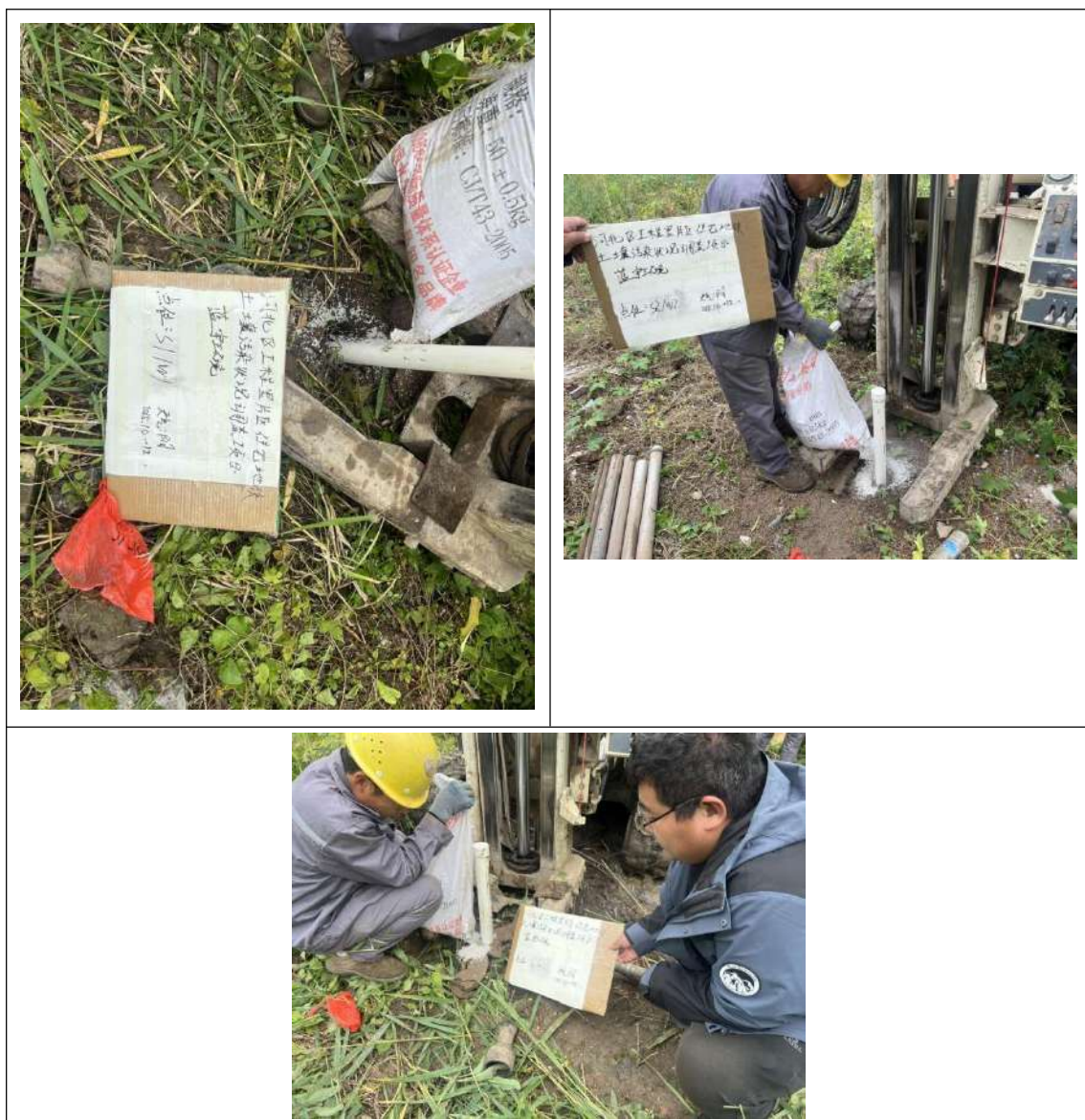
图 6-8 地下水点位滤料填充施工图
